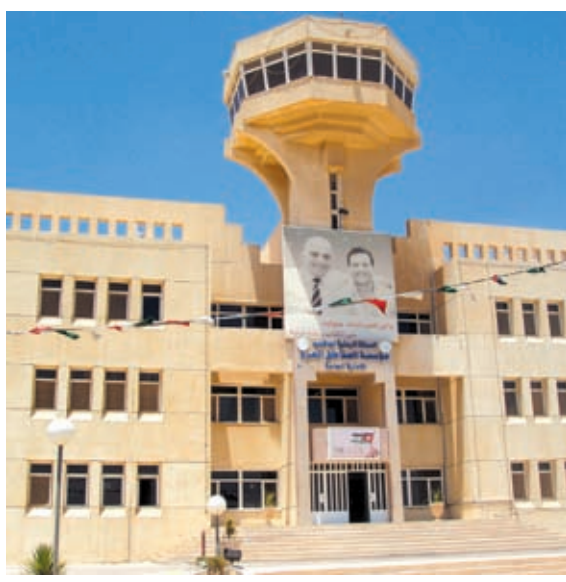
Το κτίριο διοίκησης της ελεύθερης ζώνης της Ζάρκας.
